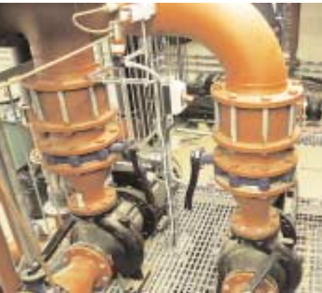
Et system for teknisk kjøling og ett for komfortkjøling.
